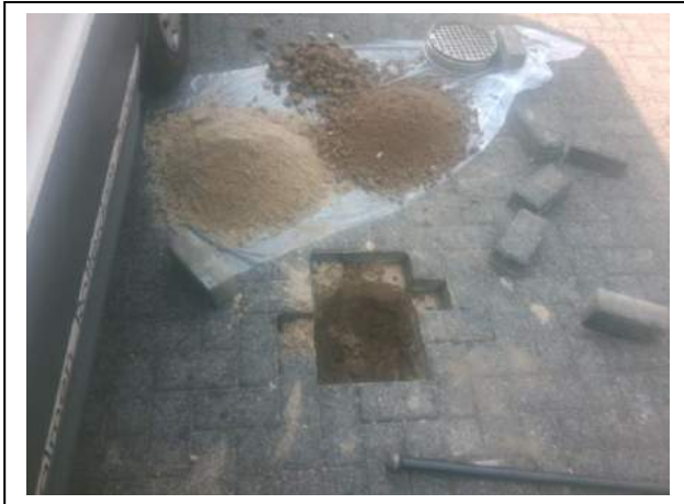
Foto 1. Asbestinspectiegat 102
