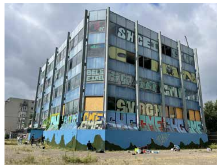
Voormalig kantoor is in de loop der tijd in verval geraakt. Ondertussen is het nu gesloopt.
