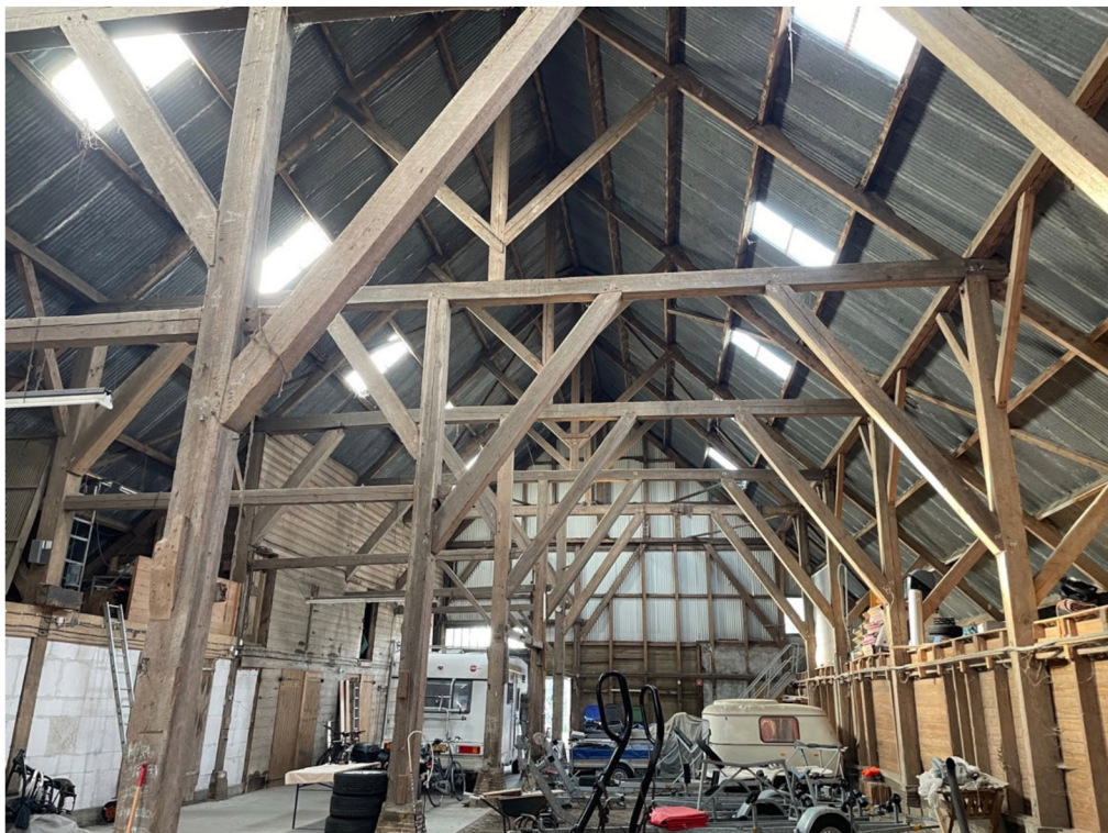
Figuur 5 binnenkant schuur met direct zicht op dakbekleding.
