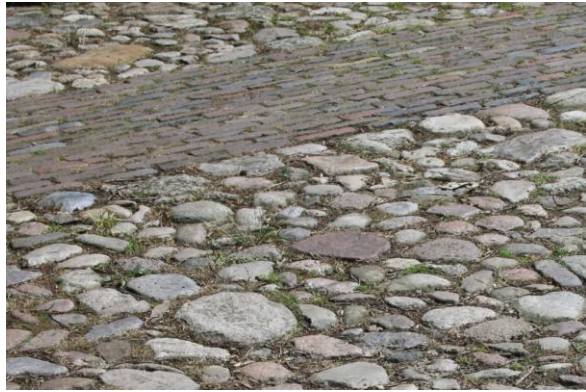
Gecombineerd verharding van ingestate keien en gravel van lokale herkomst
