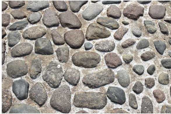
Gecombineerd verharding van ingestate keien en gravel van lokale herkomst
