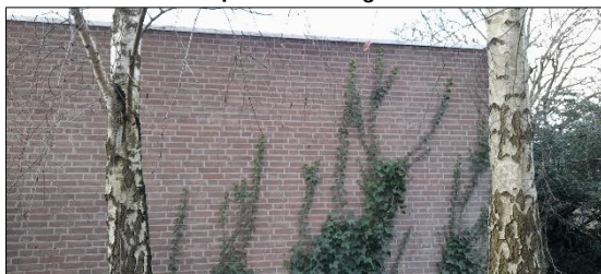
Foto 7: Muur met open stootvoegen en de de berken
