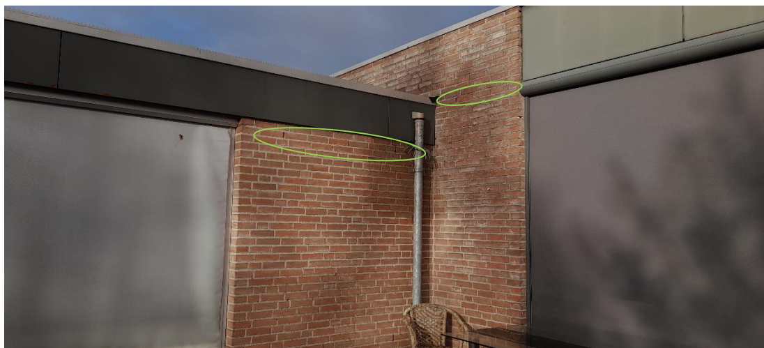
Foto 1: Een foto van de muur bij de ingang, met daarop enkele mogelijke invliegopeningen voor vleermuis (groen omcirkeld).
