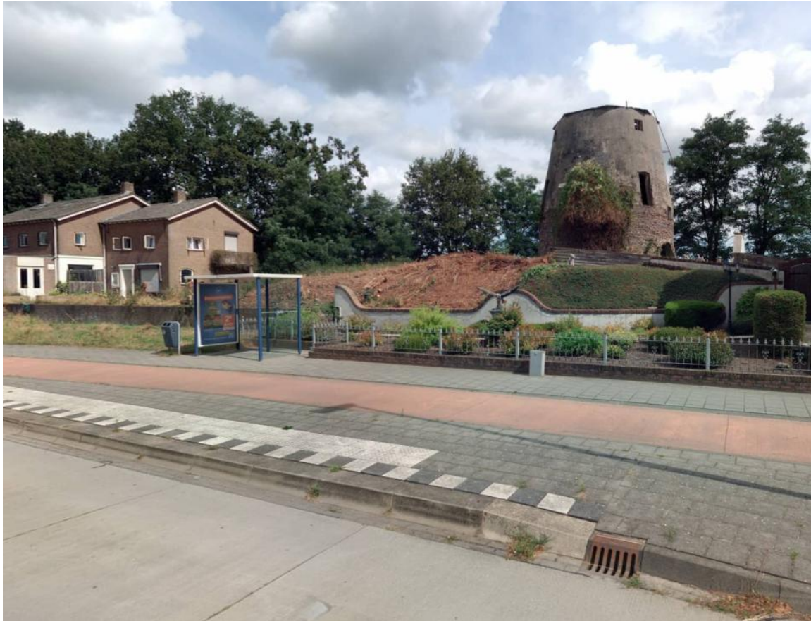
De molenramp en het voormalige restaurant gezien vanaf de Rijksweg
