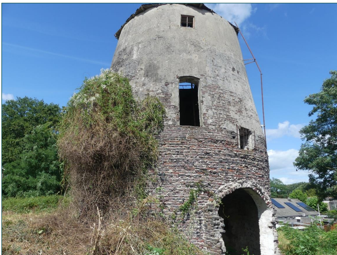
Figuur 3 De oude molenromp is opgebouwd uit enkelsteens gemetselde muren. De romp bevat diverse openingen in het dak en in de muren.
