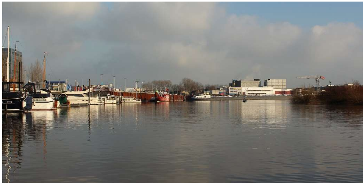
Het toeleidingskanaal van de haven
