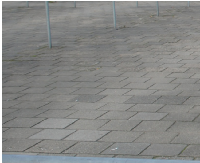
30x30 betontegels. Referentie bestaande fietsenstalling Olympus College
