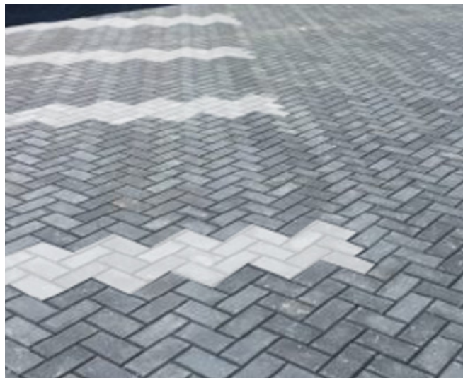
doorgaande vloer met opvallende markeringen tussen de vakken
