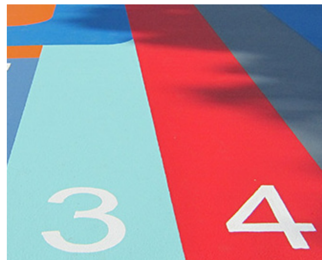
acrylcoating op elementenverharding (www.topcourts.com)
