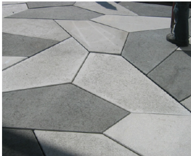
vijfhoekige betontegels: water passerende flagstone (vgl. Aquaflow (R))
