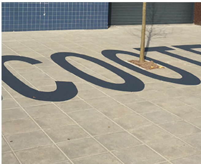
acrylcoating op elementenverharding (www.topcourts.com)
