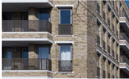
Geborgen buitenruimtes met beschutting en privacy (Lommerrijk, Amsterdam. Office Winhov)
