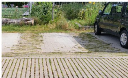
Parkeerterrein met waterdoorlatende verharding
