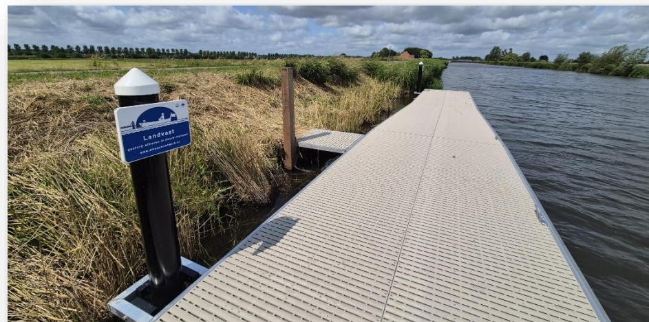
Figuur 2: Een nieuw gerealiseerde landvastlocatie inclusief bebording
